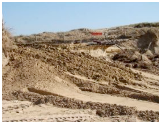
Fig. 35 – La partie terminale de la voie d'accès goudronnée à la plage de Vert-Bois a été tronquée par l'érosion.
