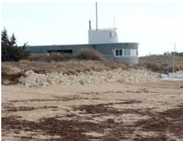
Fig. 24 – Stabilité du secteur central en raison de la présence d'un cordon d'énrochement massif.
