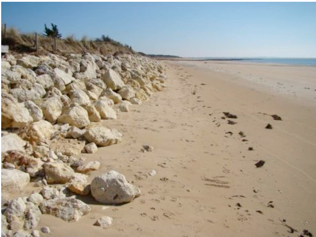
Fig. 29 – Vue vers le sud de la plage de la Rémigeasse après la tempête. Le cordon d'enrochement a protégé la dune dans la partie centrale de la plage.
