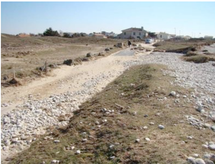
Fig. 14 – Vue vers le sud de la route côtière détruite par la tempête : on voit l'état fragmenté du cordon dunaire, qui a favorisé la pénétration des vagues et renforcé l'efficacité de leur action érosive.
