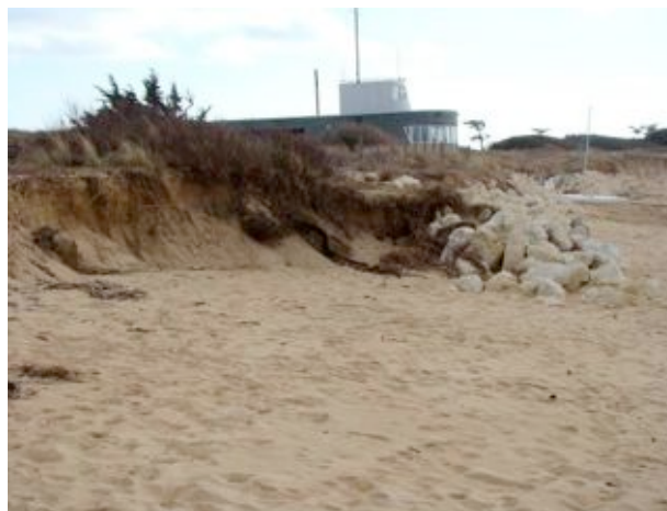
Fig. 25 – Recul de la dune au nord immédiat du cordon d'énrochement, dû à l'effet de contournement de cet ouvrage par les vagues.
