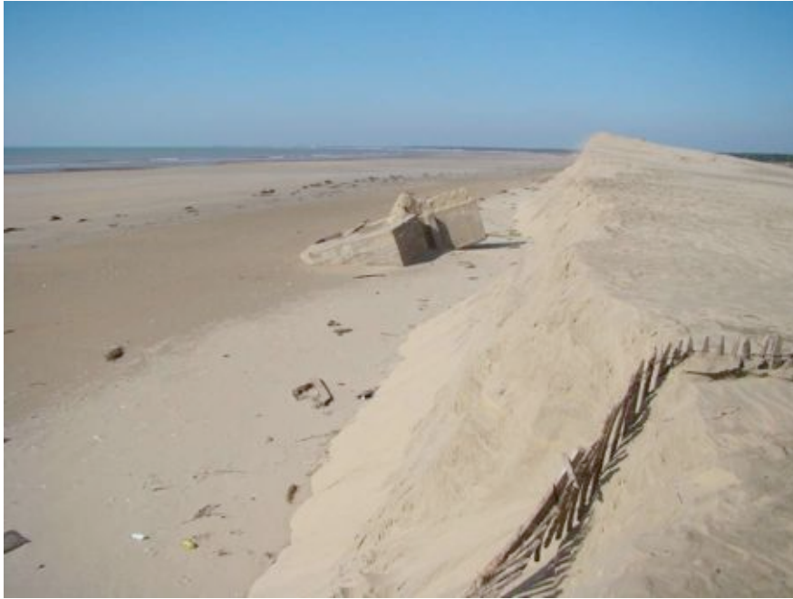
Fig. 38 – Apparition d'un nouveau blockhaus sur la plage au nord de l'accès principal après la tempête Xynthia. Cliché : V. Duvat, vendredi 5 mars 2010
