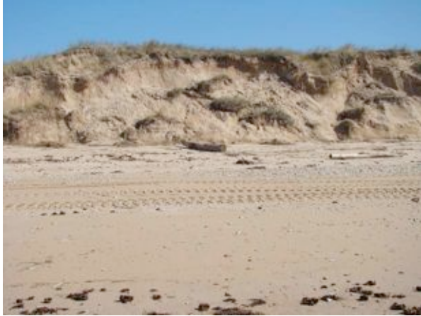
Fig. 20 – Érosion de la dune, plage des Huttes, au sud de l'accès principal.
