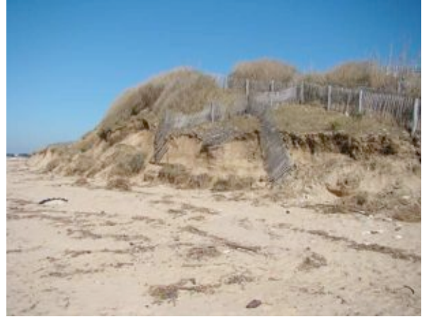
Fig. 21 – Érosion de la dune dans la zone centrale aménagée de la plage des Huttes.
