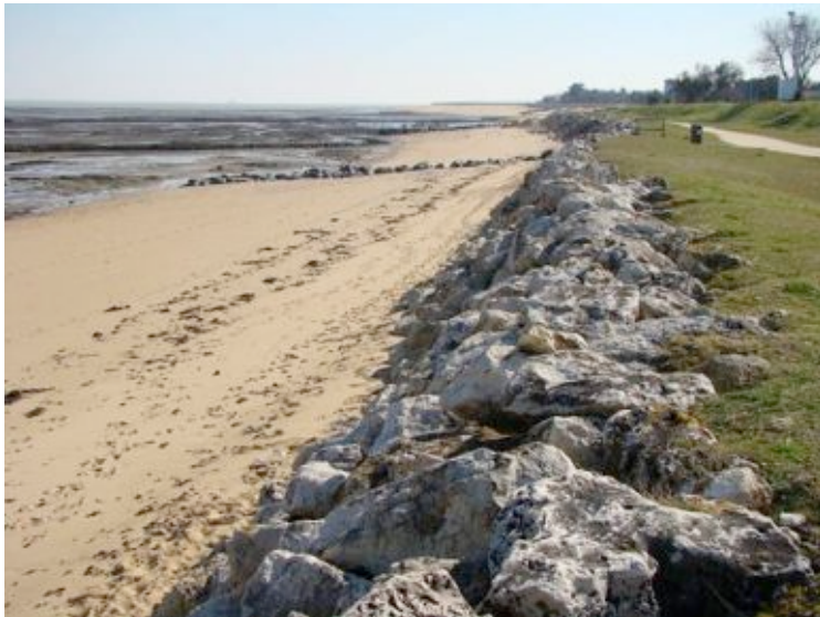
Fig. 4 – Le cordon d’enrochement qui borde la plage entre la Boierie et la pointe de Proires. L’on peut observer le bon état sédimentaire de cette plage, tout à fait comparable à celui d’avant la tempête.
