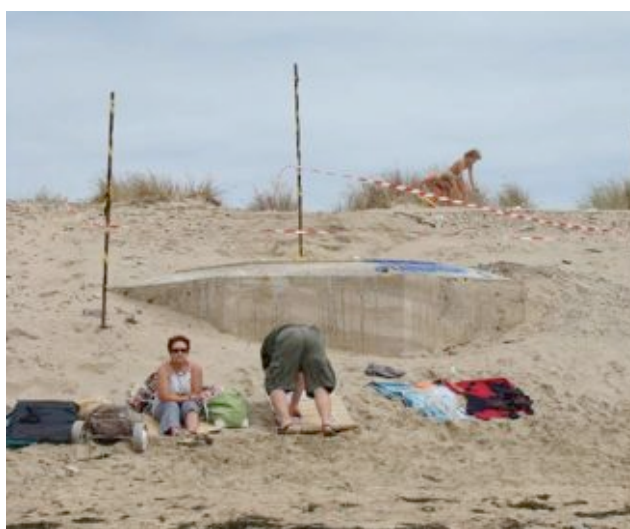
Fig. 36 – Position du blockhaus situé au sud de l'accès principal de la plage de la Giraudière le 26 juillet 2009.
