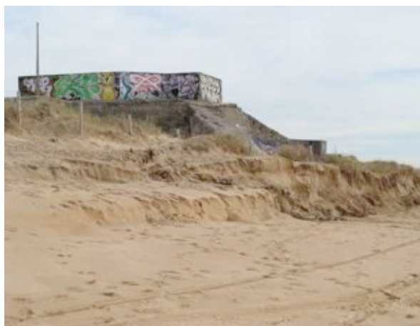
Fig. 32 – Position du blockhaus nord de la plage de Vert-Bois au 30 janvier 2009, après une tempête d'intensité moyenne.
