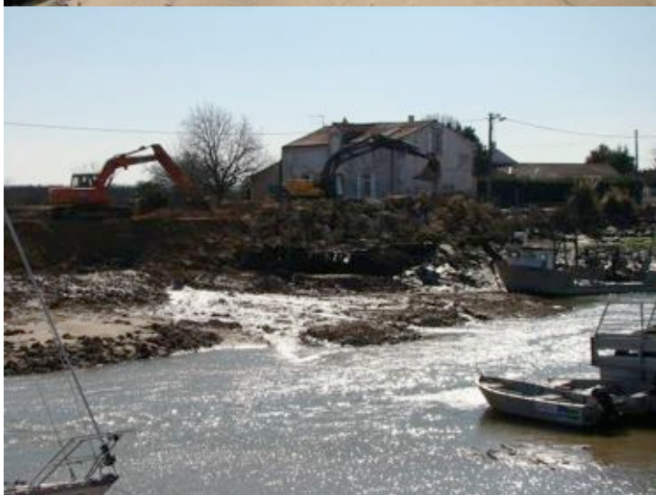
Fig. 11 – Travaux de réfection des berges dans la partie aval du chenal de la Perrotine une semaine après le passage de la tempête.
