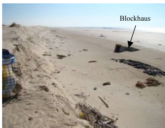
Fig. 37 – La position du même blockhaus après la tempête Xynthia témoigne d'une recul de la dune de plus de 20 mètres.
